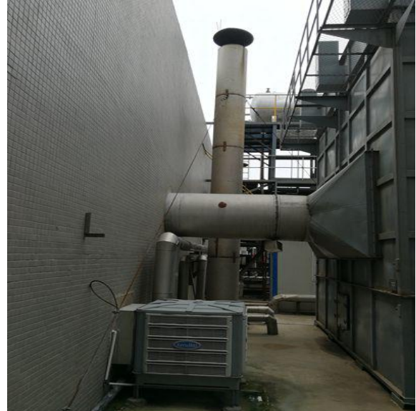
天然气锅炉排气筒
