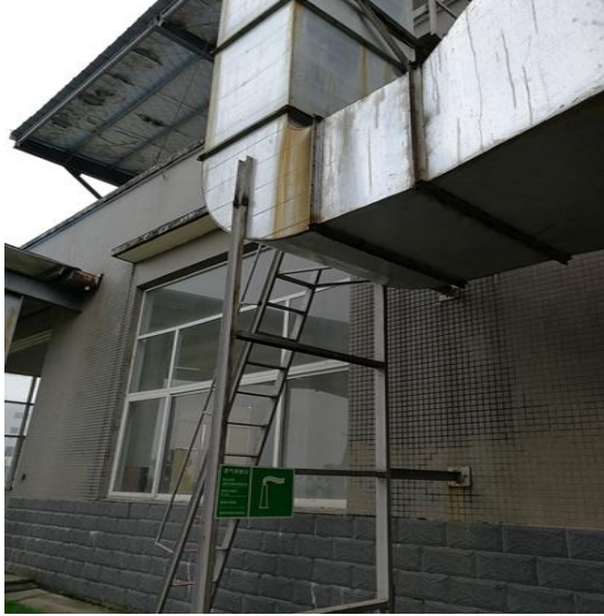
粉尘处理设施排放口
