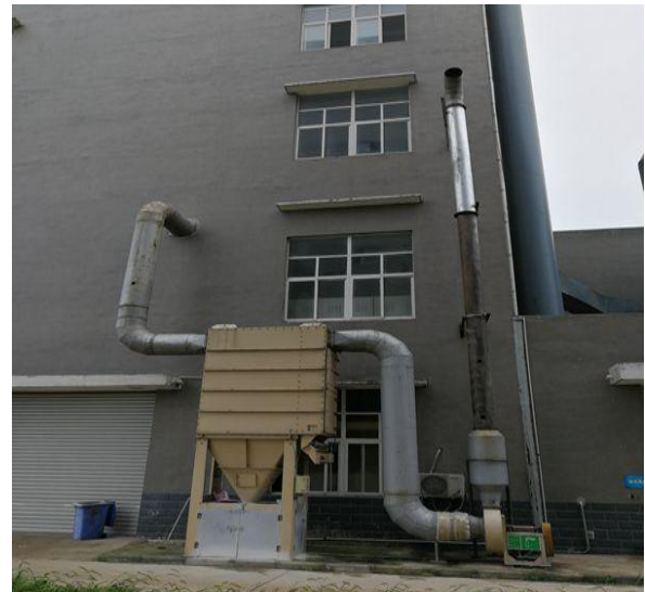
粉尘处理设施
