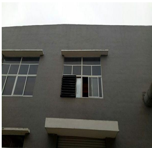
车间通风设施
